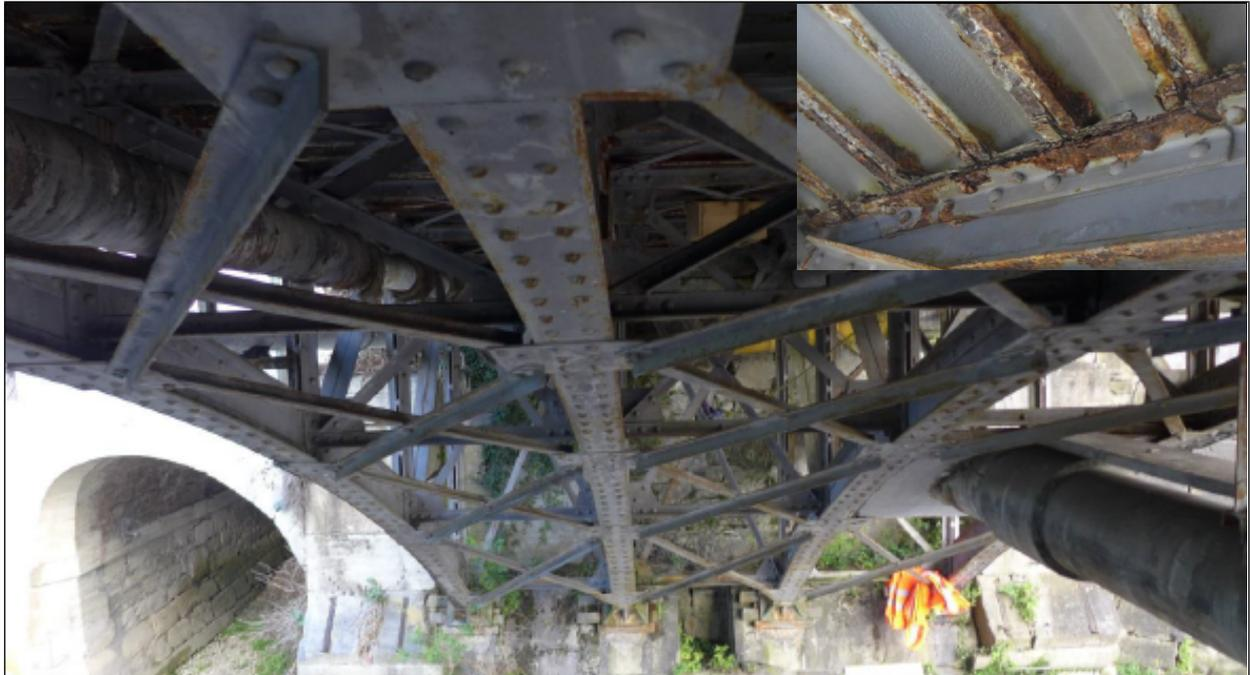
Der Korrosionsschutz ist generell in einem schlechten Zustand. Die Korrosionsschutzbeschichtung weist an vielen Stellen Rostflecken auf. Der Anschluss einer oberen Diagonalstrebe ist infolge Rost gebrochen.
