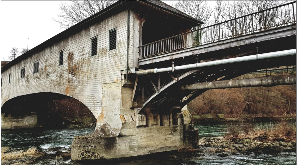
Als Sofortmassnahme wurden weitere provisorische Verstärkungsmassnahmen ausgeführt, um die Tragsicherheit der Konstruktion vorerst gewährleisten zu können. Da der Zustand des Primärtragwerks sich weiter verschlechtert, sollte die Sanierung zeitnah an die Hand genommen werden.
