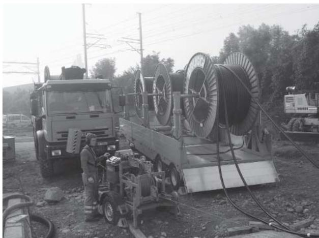
HS-Kabelzug Kraftwerk Wettingen–TS Rosenau (Kabel  $3 \times 1 \times 500 \text{ mm}^2$ )
