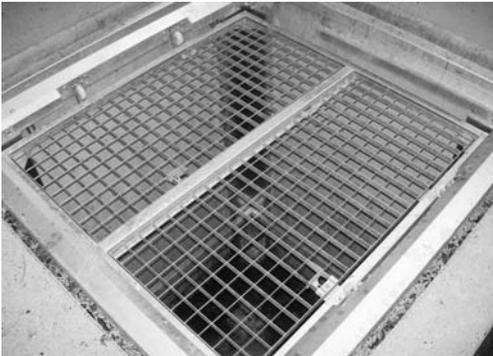
*Sicherheitsgitter wird beim Anheben und Entfernen des Containers automatisch hochgefahren*
