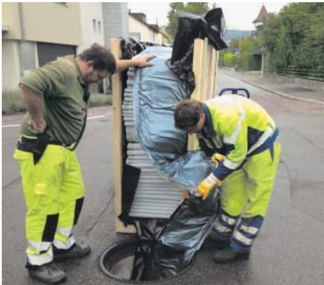
*Einzug des vorkonfektionierten Liners über den Kontrollschacht in die zu sanierende Abwasserleitung.*
