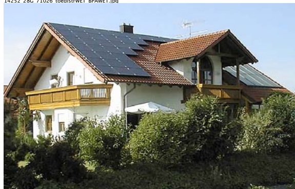
Abb. 5: Die versuchte Anpassung an die Dachform misslingt. Es herrscht eine Disharmonie der Formen. Besser wäre eine Aufteilung in zwei rechteckige Felder, symmetrisch beidseitig der Dachgaube angeordnet. Plisting, Deutschland. (Foto: auto.pege.org) 14252_28G_71026_plistingDE_auto_pege_org.jpg
