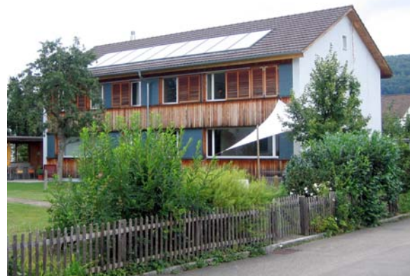
Abb. 8: Die Solaranlage liegt parallel zu den Dachkanten und nimmt so die Konturen des Gebäudes auf. Bernastrasse, Wettingen (Foto: Bau- und Planungsabteilung Wettingen) 14252_28G_71026_bernaustrWET_BPAWET.jpg
