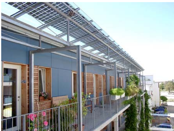
Abb. 2: Bei Neubauten können Solaranlagen gestalterisch wie funktional vollständig integriert werden. Freiburg im Breisgau, Deutschland (Foto: passivhaus-vauban.de) 14252_28G_71026_vauban_freiburgDE_passivhaus_vauban_de.jpg
