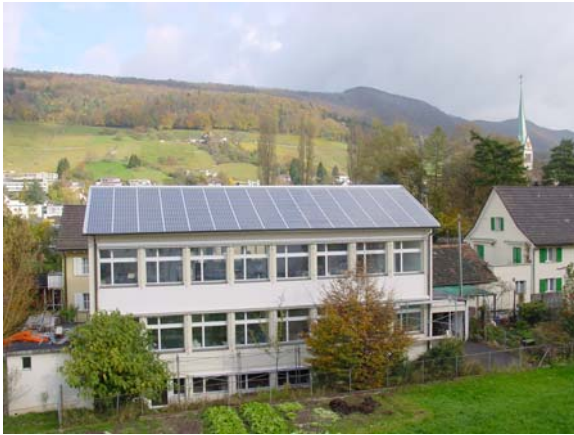
Abb. 6: Vollintegration als gute Lösung: Das Ziegeldach wurde vollständig durch eine Solaranlage ersetzt. Lindenplatz 5, Wettingen (Foto: SKK Landschaftsarchitekten AG, Wettingen) 14252_05A_080218_SKK_Foto.jpg
