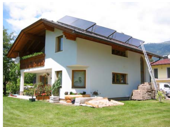
Abb. 9: Orientierung und Neigung des Daches werden ignoriert, was zu einer optischen Beeinträchtigung der Gesamtsituation führt. Tristach, Österreich (Foto: fagerer.at) 14252_28G_71026_tristachAT_fagerer_at.jpg
