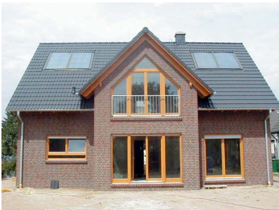
Abb. 7: Die beiden Felder der Solaranlage übernehmen die Symmetrie des Gebäudes. Ein harmonisches Gesamtbild entsteht. Berlin, Deutschland (Foto: solar-systeme.de) 14252_28G_71026_gusseckhaus_berlinDE_solar_systeme_de.jpg
