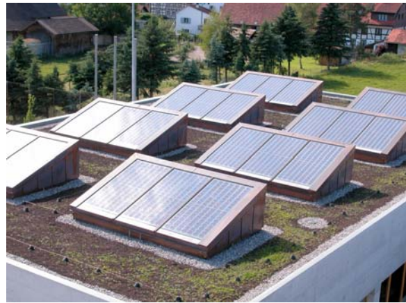
Abb. 11: Die Felder der Solaranlage respektieren einen gebührenden Abstand zu den Dachkanten. Die Regelmässigkeit gleicher Formen erzeugt ein harmonisches Bild. (Foto: Emanuel Schoop, Ortsbildberater der Gemeinde Wettingen) 14252_28G_71026_DSCN1116_schoop.jpg
