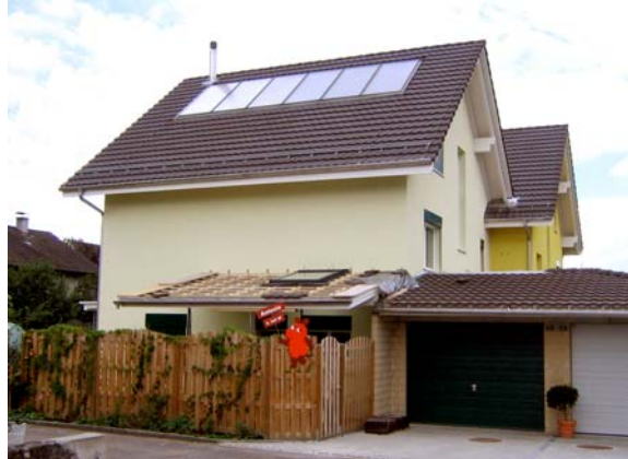
Abb. 3: Die Dachbündigkeit der Solaranlage wirkt integrierend. Die Anlage wird Teil der Gebäudehülle. Attenhoferstrasse, Wettingen (Foto: Bau- und Planungsabteilung Wettingen) 14252_28G_71026_attenhoferstr_WET_BPAWET.jpg
