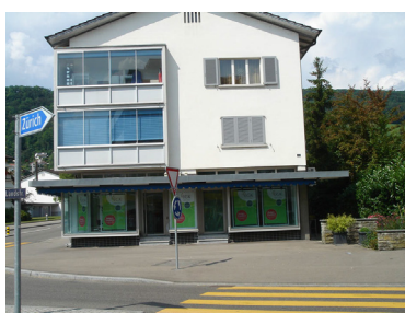
Grosszügige, jedoch ungenutzte Vorzone
