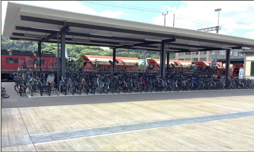
Foto: Veloabstellanlage östlich des Bahnhofgebäudes
