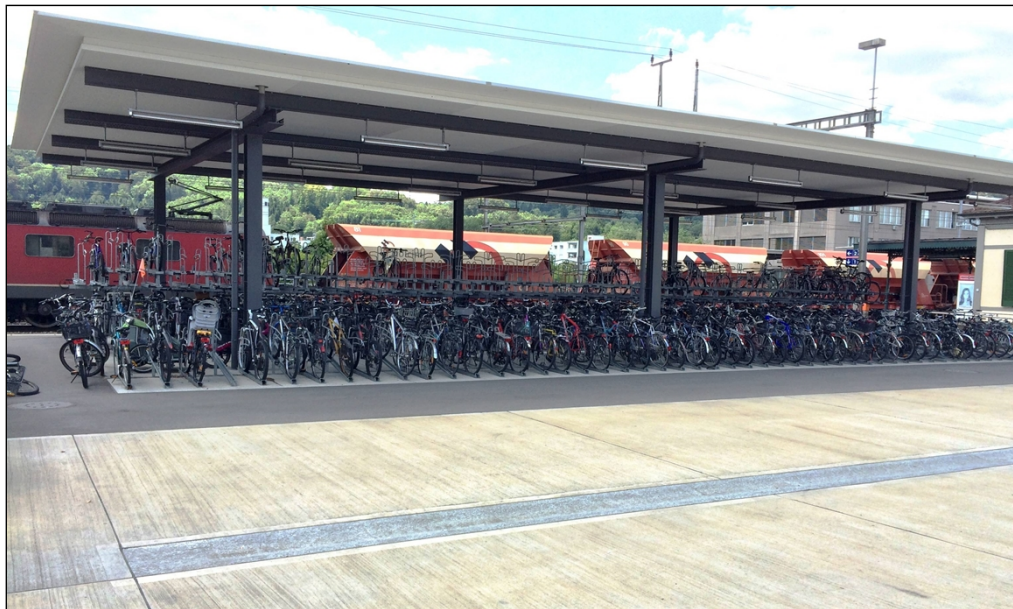
Foto: Veloabstellanlage östlich des Bahnhofgebäudes
