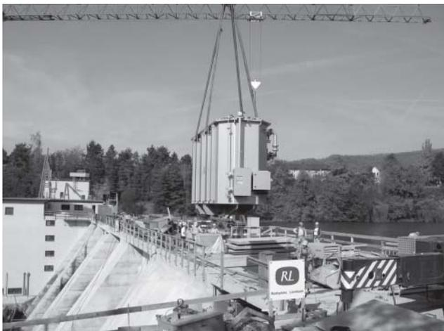
Trafo 110/16 kV beim Kraftwerk Wettingen (EWZ)
