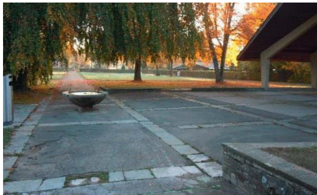
Vor der Instandstellung
