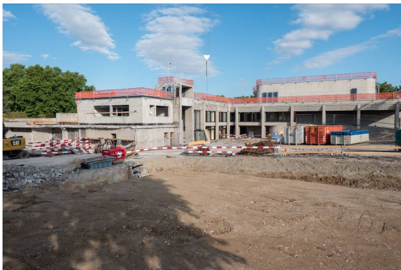
Abbildung 14: Rohbau zu Beginn der Baustelle
