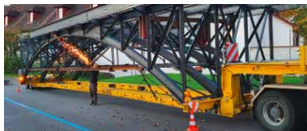
Sanierung der Holzbrücke.
