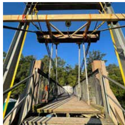
Instandsetzung der Paul-Fischer-Brücke (Gwagglibrugg).
