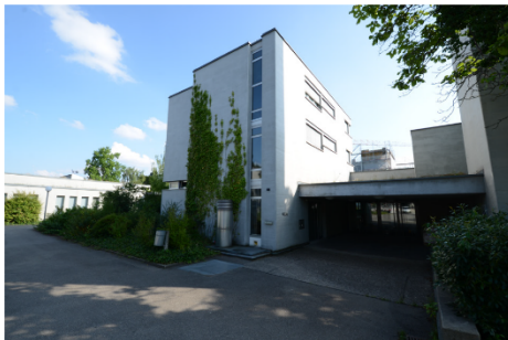
Margelstrasse 4, Ansicht von Nordwesten, 31.07.2014.
