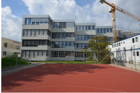
Margelstrasse 8, Ansicht von Osten, 25.09.2014.
