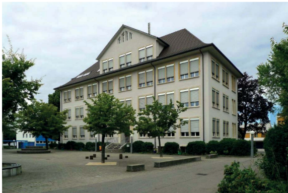
Ansicht Hauptfassade von Nordosten (2014)
