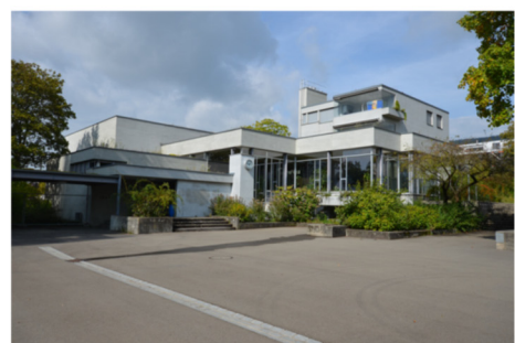
Margelstrasse 4, Ansicht von Südosten, 25.09.2014.
