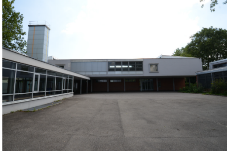
Alb. Zwysigstrasse 72-74, Ansicht nördlicher Innenhof, 31.07.2014.
