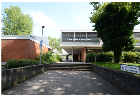
Alb. Zwysigstrasse 72-74, Ansicht von Westen, 31.07.2014.
