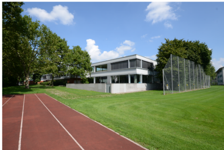
Alb. Zwysigstrasse 72-74, Ansicht von Südwesten, 31.07.2014.
