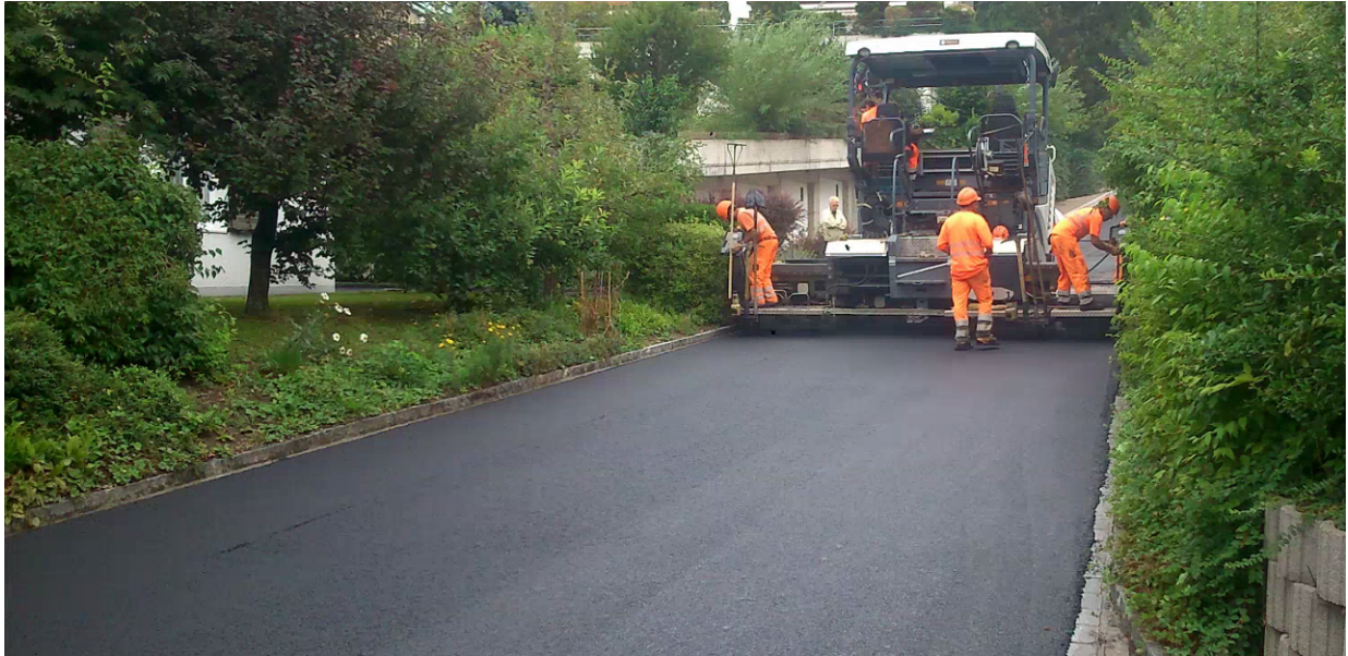
Abb. 2: Deckbelagseinbau - Schönenbühlstrasse
