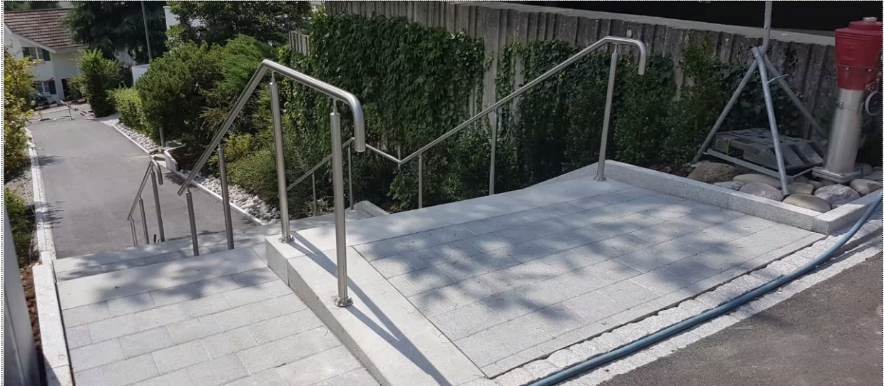
Abb. 6: Neue Treppe Lehweg / Hintere Höhenstrasse
