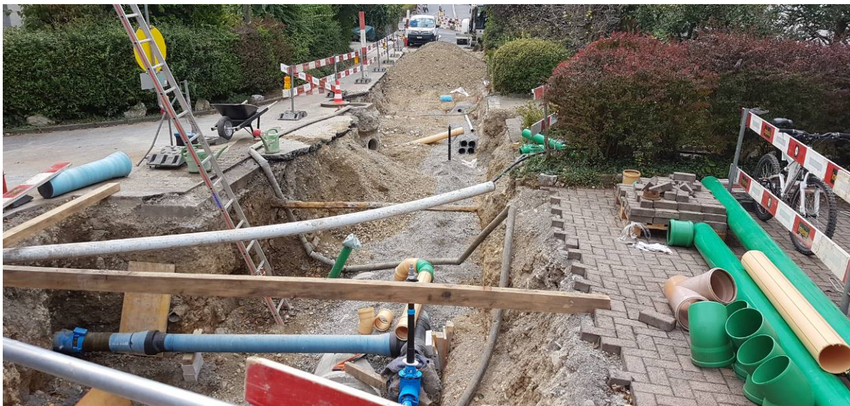
Abb. 3: Kanalbau – Sauberwasserleitung
