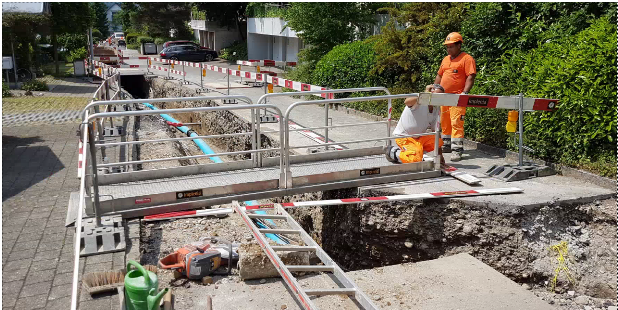
Abb. 7: Trinkwasserleitungsbau - Schönenbühlstrasse
