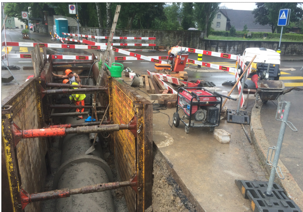
Abb. 4: Kanalbau – Sauberwasserleitung – Querung Schartenstrasse
