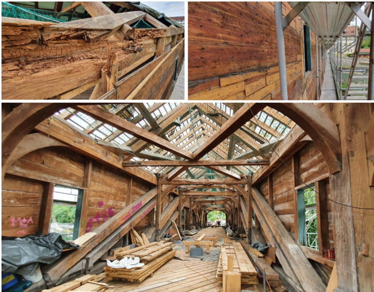
Im Rahmen der Sanierung wurde die Holzkonstruktion ertüchtigt, das Dach unter Verwendung der alten Biberschwanzziegel abgedichtet, der Bodenbelag mit Massivholzbohlen ausgetauscht und die asbesthaltenden Faserzementschindeln durch eine Schindelbekleidung aus Lärchenholz ersetzt.
