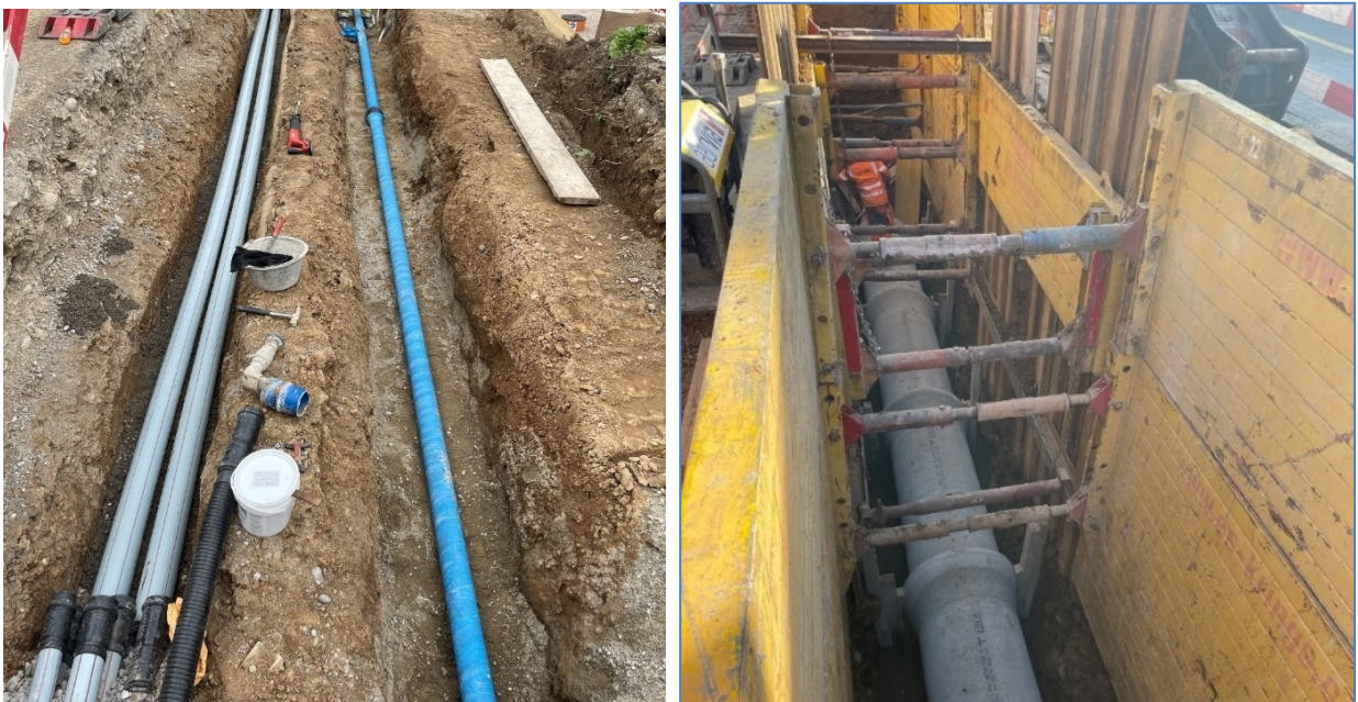
Abb. 3: Erneuerung der Werkleitungen Abwasser, Elektrizitäts- und Wasserversorgung
