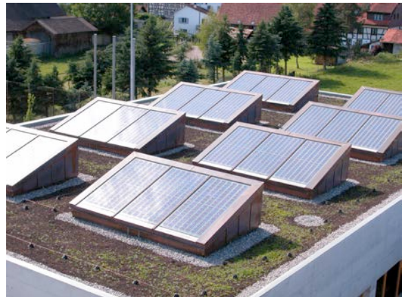
Abb. 11: Die Felder der Solaranlage respektieren einen gebührenden Abstand zu den Dachkanten. Die Regelmässigkeit gleicher Formen erzeugt ein ruhiges Bild.
