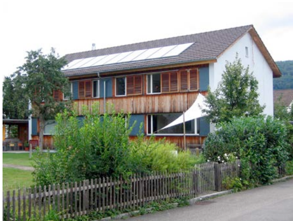
Abb. 8: Die Solaranlage liegt parallel zu den Dachkanten und nimmt so die Konturen des Gebäudes auf. Bernastrasse, Wettingen
