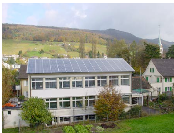
Abb. 6: Vollintegration als gute Lösung: Das Ziegeldach wurde vollständig durch eine Solaranlage ersetzt. Beispiel Lindenplatz 5, Wettingen
