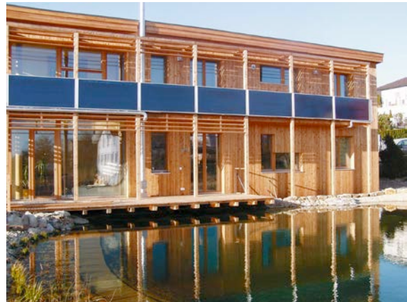
Abb. 10: Die Solaranlage tritt bewusst als gestalterisches Element in Erscheinung und fügt sich dennoch ein, da sie durch Formsprache und Anordnung die Gebäudekanten aufnimmt.
