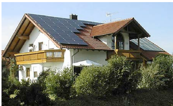
Abb. 5: Die versuchte Anpassung an die Dachform misslingt. Es herrscht eine Disharmonie der Formen. Besser wäre eine Aufteilung in zwei rechteckige Felder, symmetrisch beidseitig der Dachgaube angeordnet.
