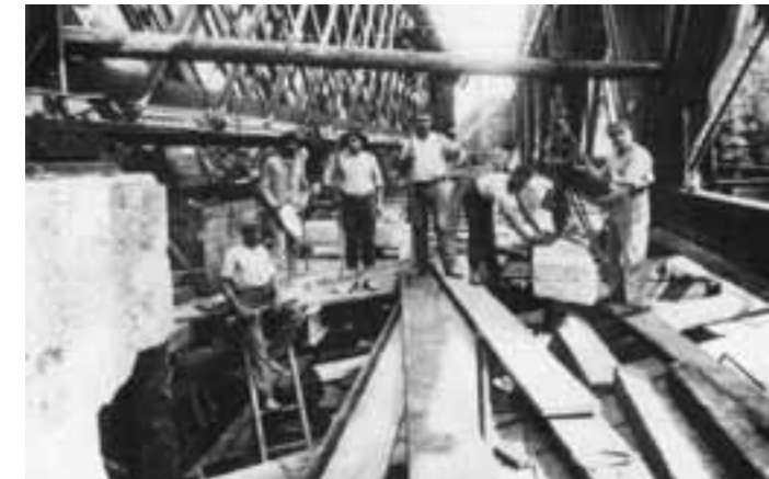
SBB-Arbeiter verbreitern und renovieren die Eisenbahnbrücke Baden-Wettingen 1922
